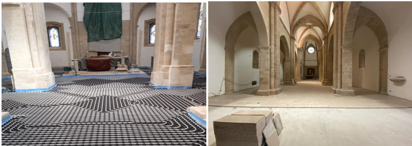
Realizzazione impianto di riscaldamento e posa in opera nuova pavimentazione
